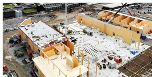
Bau des EcoDataCenters in Falun aus CLT.
