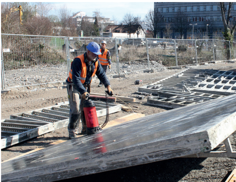
Die Wahl des richtigen Trennmittels für die Verschalung ist ergebnisrelevant.
